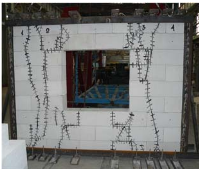
Рис. 7. Разрушение эталонного образца
