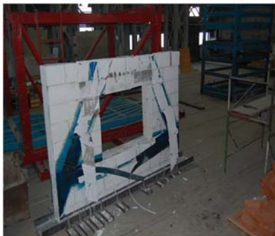
Рис. 8. Разрушение усиленного образца
