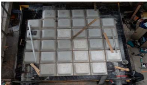
Рис. 1. Общий вид опалубки под плиту перед установкой арматурных каркасов
