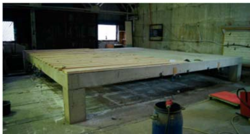
Рис. 3. Общий вид опытного образца после бетонирования
