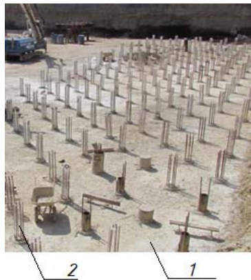
Рис. 3. Свайное поле из буройнъекционных свай ЭРТ: 1 – бетонная подготовка; 2 – выпуски армокаркаса свай ЭРТ
