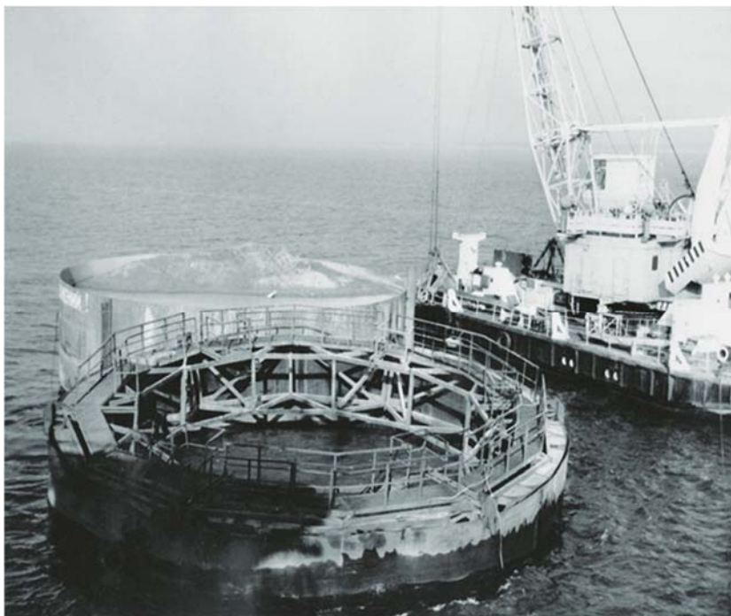
Монтаж перемычек котлована
