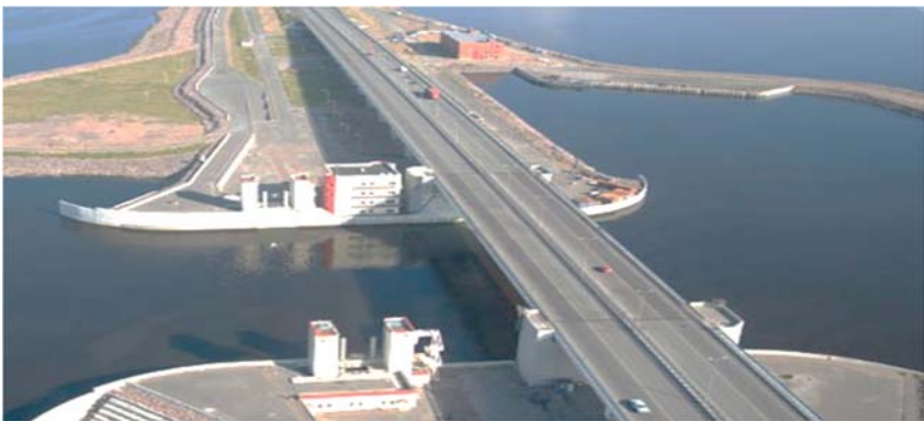
Автомобильный мост с подъемным пролетным строением над судопропускным сооружением С-2
