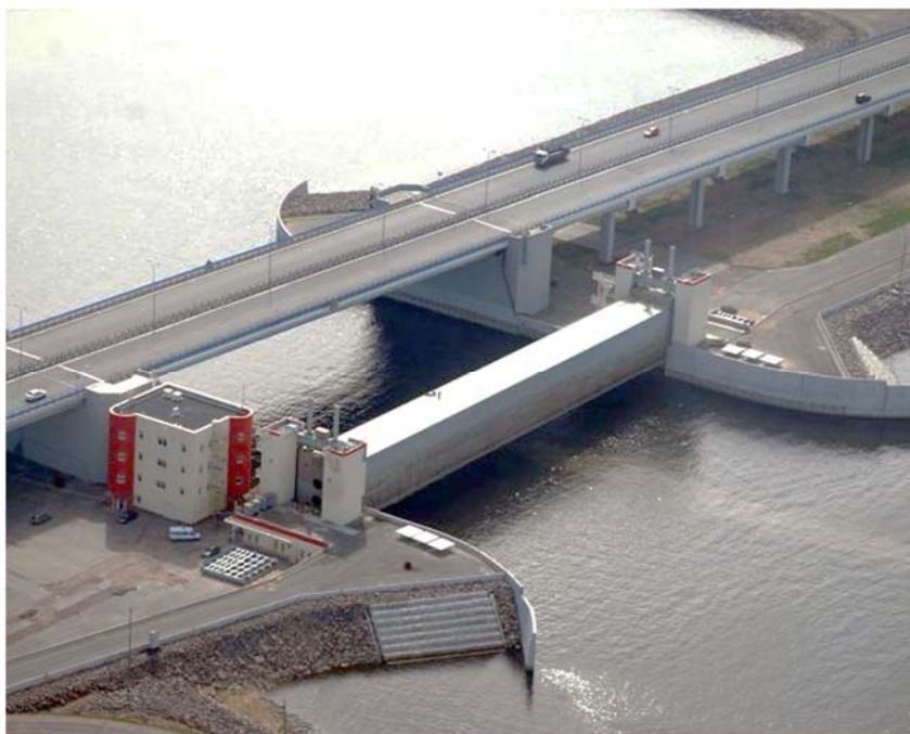
Плоский затвор судопропускного сооружения С-2
