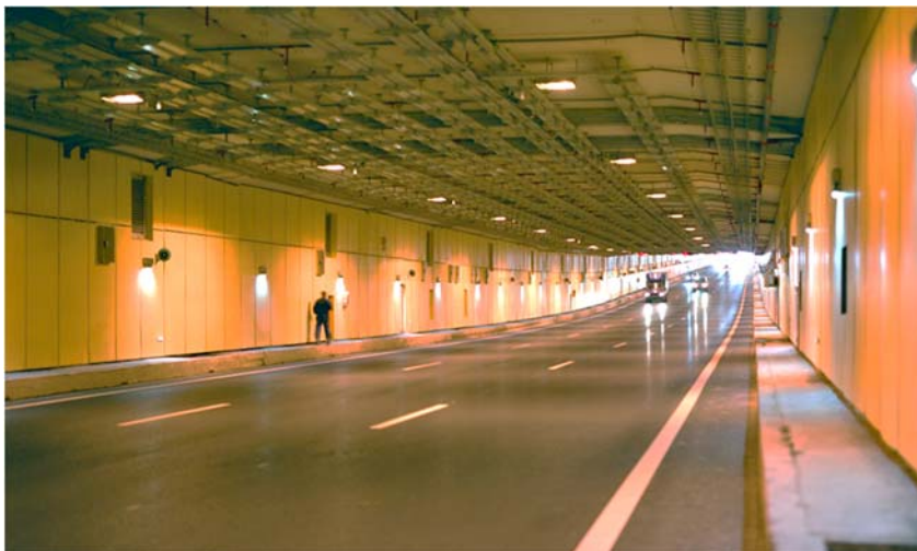
Вид тоннеля внутри
