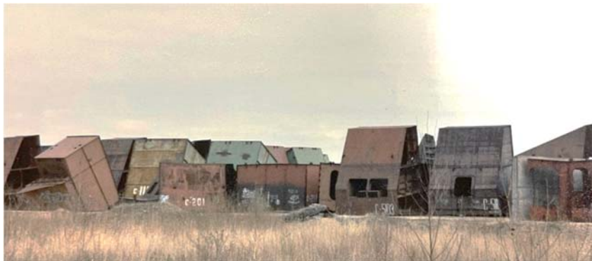
Ржавеющие блоки батопорта
