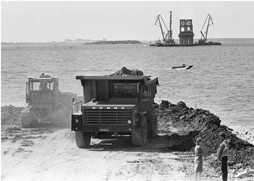
Отсыпка насыпи дамбы
