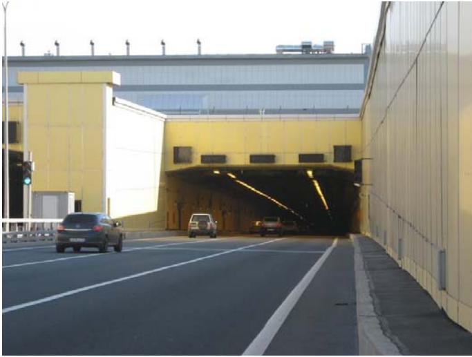
Вид на тоннель со стороны портала
