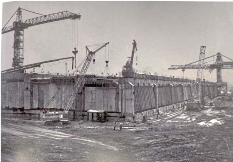
Строительство наплавных блоков водопропускных сооружений КЗС в районе п. Горская
