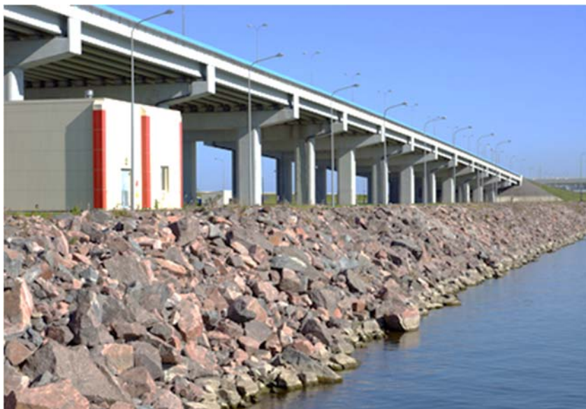
Балочные железобетонные пролетные строения эстакадной части моста
