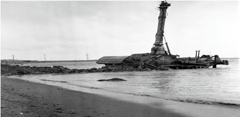
Работающая техника на строительстве комплекса
