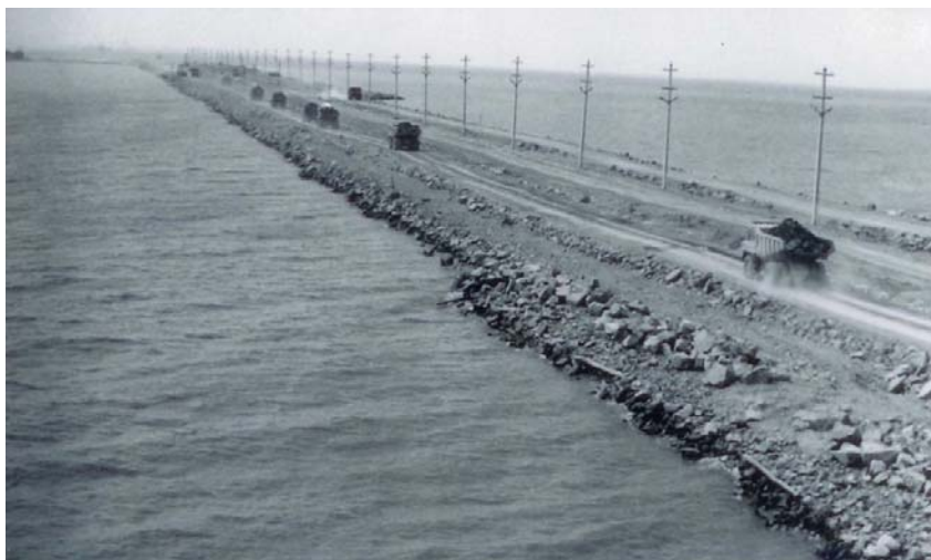
Создание сухопутного проезда на остров Котлин
