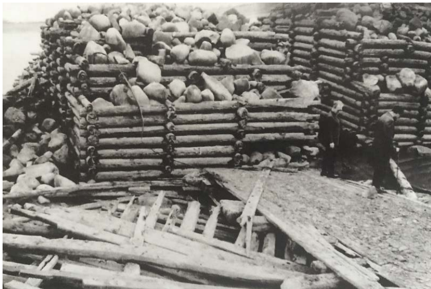
Деревянные ряжи петровской эпохи
