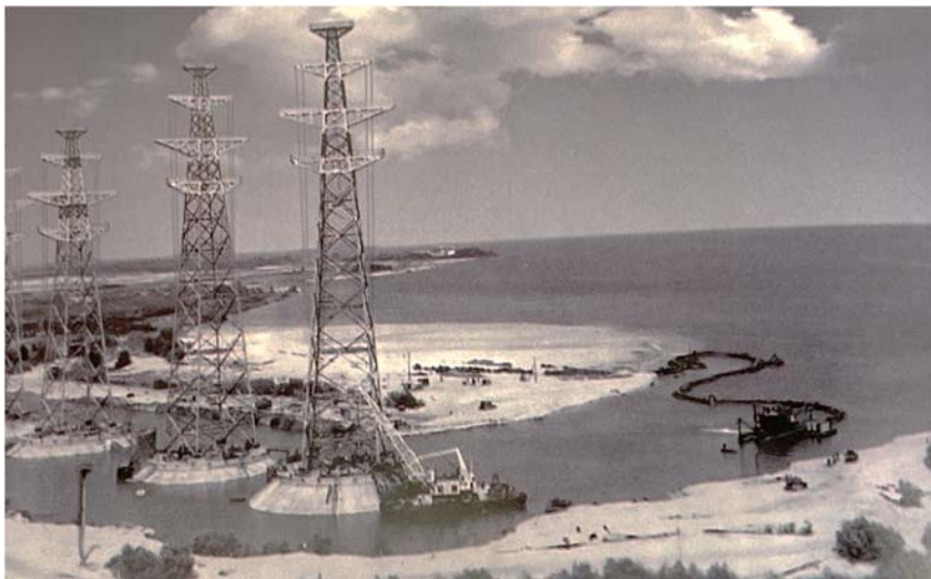
Транспортировка наплавных опор линий электропередач ВЛ 330 кВ высотой 126 м. Каховское водохранилище
