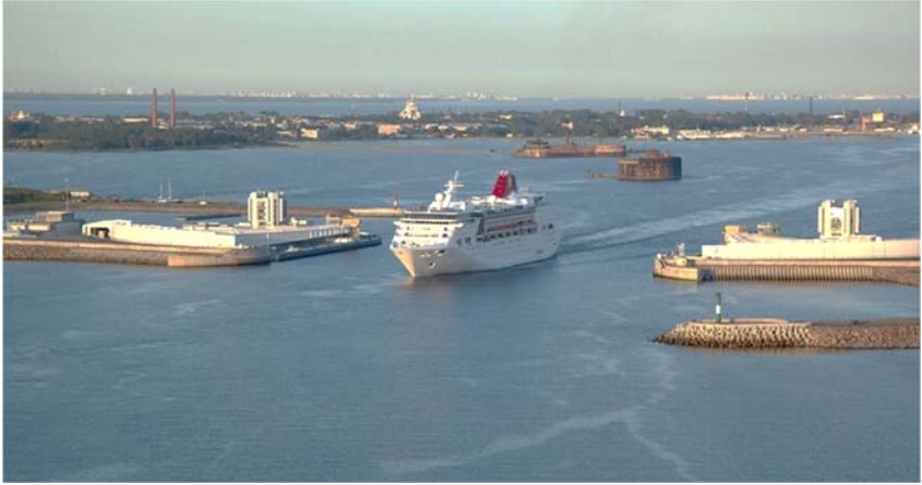
Общий вид на судопропускное сооружение С-1
