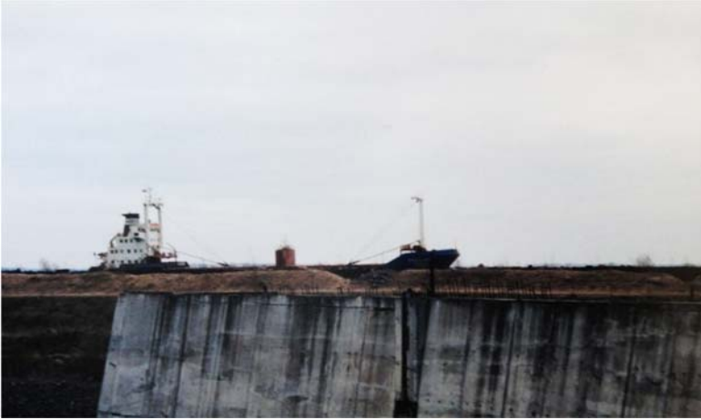
Провод судов в непосредственной близости от котлована С-1
