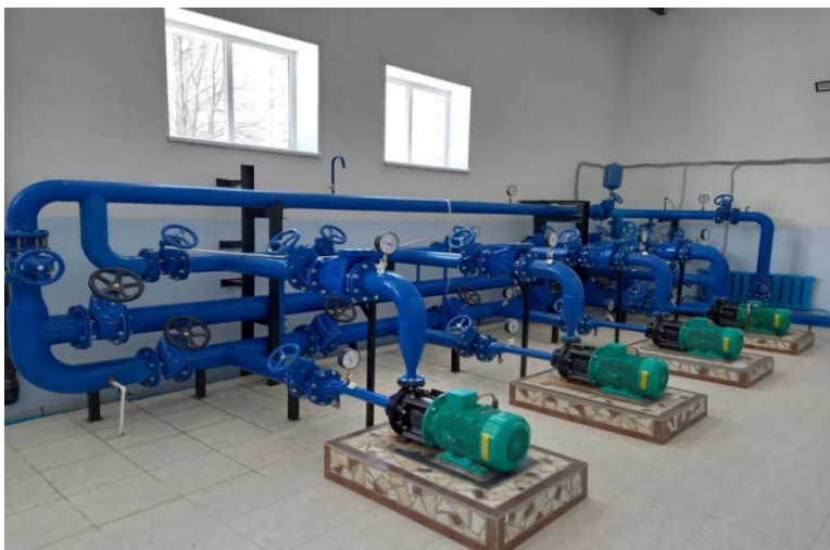
Рисунок 2 – Реконструкция насосного оборудования в машинном зале ЦТП №1
