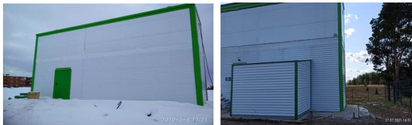
Рисунок 1 – Биологические очистные сооружения п. Северный Заволжской части г. Чебоксары
