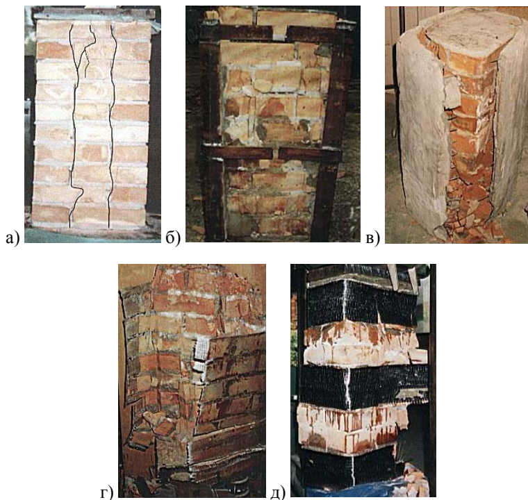
Рис. 4. Механизмы разрушения экспериментальных кирпичных столбов без усиления (а) и с усилением металлической обоймой (б), армированной штукатуркой (в), стеклопластиковыми (г) и углепластиковыми сетками (д)
