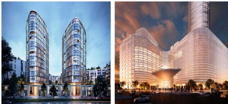
Рис. 7. Строительные конструкции с технологиями BubbleDeck
