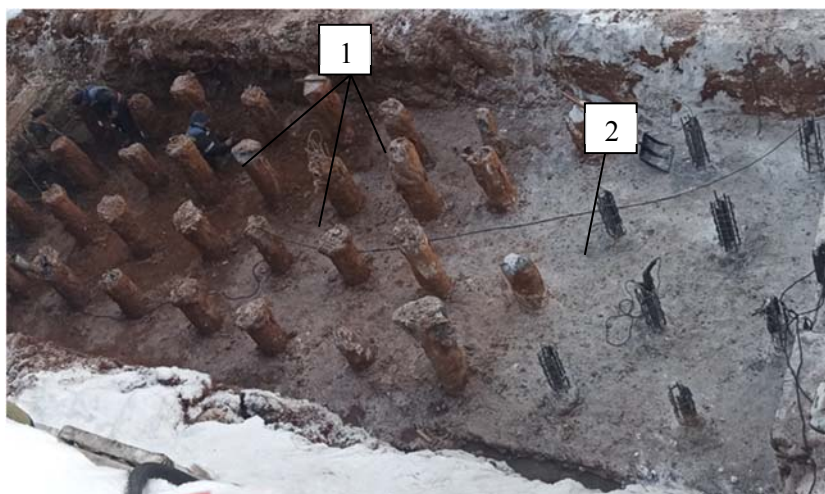
Рис. 2. Свайное поле под монолитный железобетонный контрфорс: 1 – оголовки буроналивных свай ЭРТ; 2 – бетонная подготовка под ростверк
