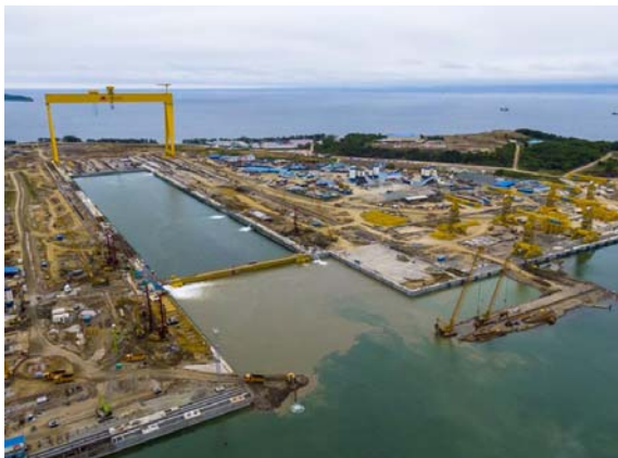
Рис. 1. Общий вид сухого дока, заполненного водой
