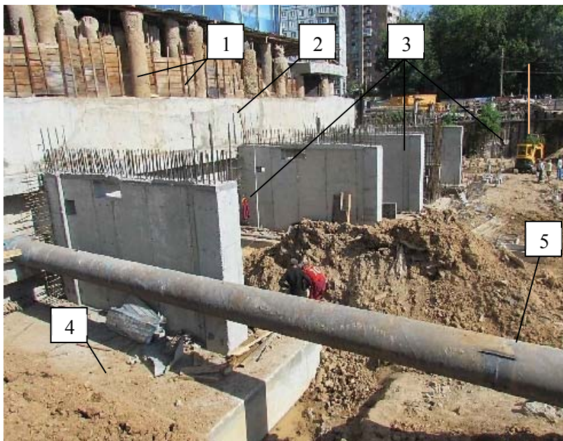
Рис. 3. Фрагменты выполненных монолитных железобетонных контрфорсов: 1-существующие буронабивные сваи ограждения котлована; 2-ограждение котлована из монолитного железобетона; 3-монолитные железобетонные контрфорсы усиления существующей подпорной стены; 4-монолитный железобетонный ростверк; 5-существующая труба – расстрел усиления
