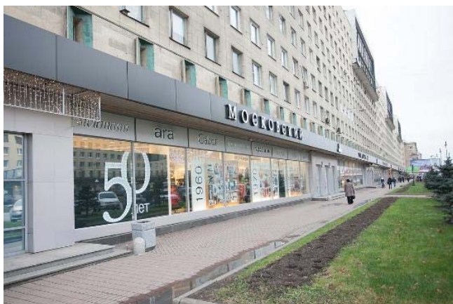
Рис. 5.3. Универмаг «Московский»: одна из двух полукилометровых частей, расположенных на противоположных сторонах десятиполосного Московского проспекта, соединенных тремя пешеходными переходами
