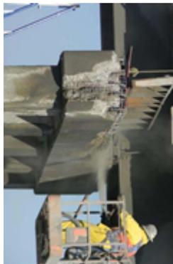
При устройстве и восстановлении футеровки, нанесении огнеупорных покрытий на сталеплавильных предприятиях (Россия)
