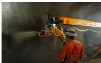
Рис. 4. Торкретирование методом плотного потока
