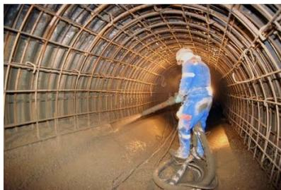
Рис. 2. Примеры реконструкции зданий и сооружений из торкретжелезобетона в России
