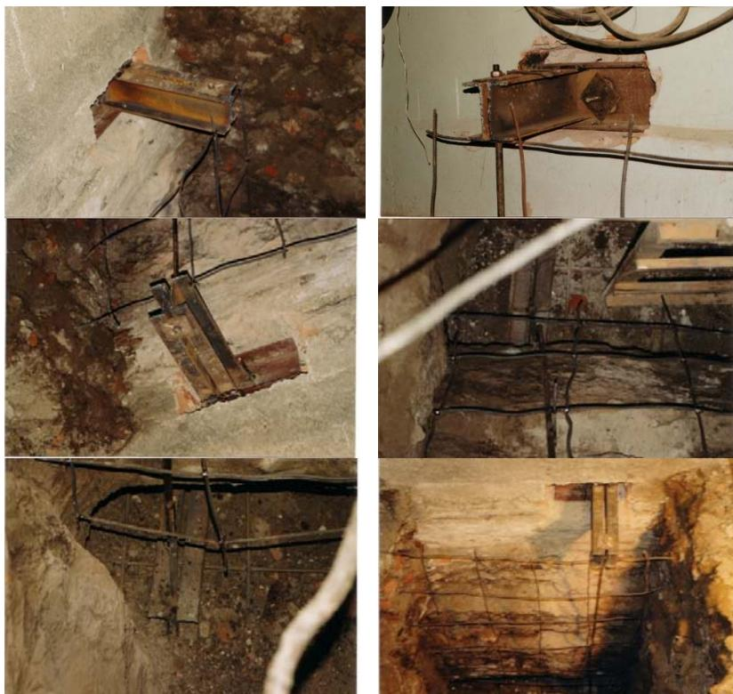
Рис. 42. Подготовка поверхности к торкретированию
