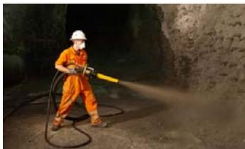
Рис. 3. Процесс тонкоструйного торкретирования
