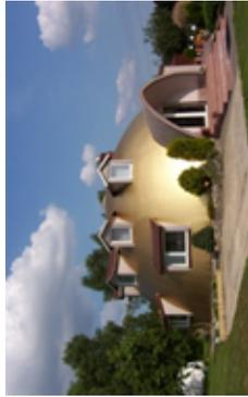
Безопалубочное монолитное строительство зданий с крупнообразными, округлыми формами (США)
