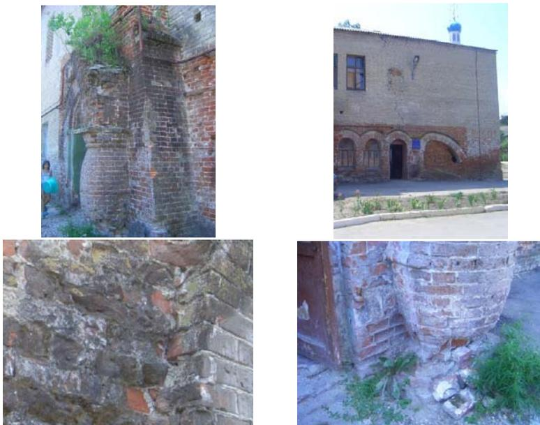
Рис. 48. Элементы разрушения западного фасада
