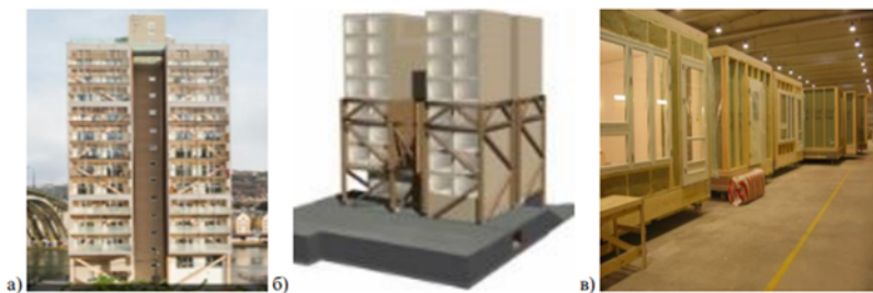
Рис. 2. 14-ти этажное жилое здание Treet (г. Берген, Норвегия): а) фасад здания, б) часть конструктивной системы; в) модули заводской готовности
