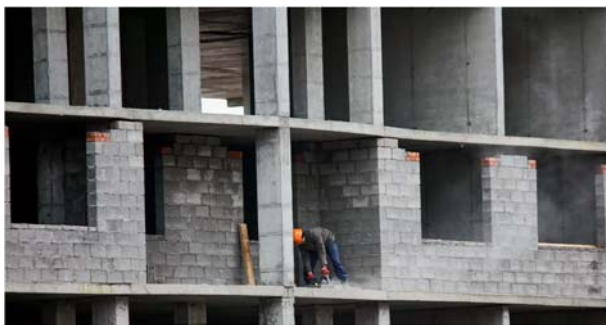
Рис. 2. Пример организации проема в ограждающей конструкции
