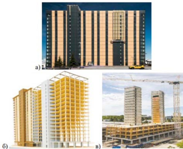
Рис. 4. 8-ти этажное здание общежития Brock Commons (г. Ванкувер, Канада): а) фасад здания, б) конструктивная система; в) процесс строительства здания
