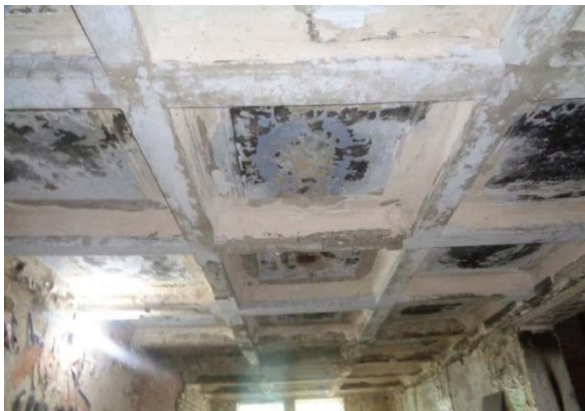
Рис. 2. Междуэтажное кессонное перекрытие кинотеатра «Родина» в г.Волжске РМЭ (по состоянию на 2024 г.)
