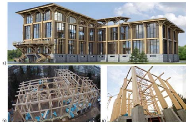
Рис. 3. Офисное здание GOOD WOOD PLAZA (д. Елино, Московская обл.): а) модель здания, б) конструктивная система; в) опирание колонн на ж/б «основу» здания
