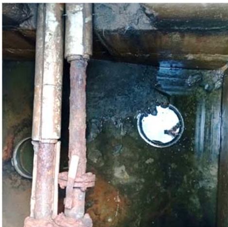
Рис. 1. Состояние трубы трубопровода \varnothing 76X3,5
