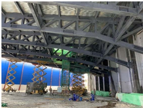
Рис. 3. Примыкание ферм к стене
