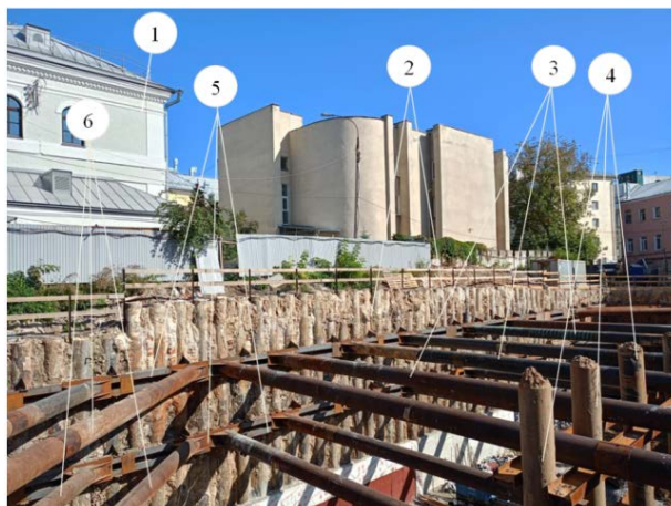
Рис. 4. Схема открытого строительного котлована глубиной 11,0 м вблизи двухэтажного здания ОКН (поз.1) с ограждением из стальных труб, заполненных бетоном (поз. 2), распорок (поз. 3), стоек из стальных труб, заполненных бетоном (поз. 4), стальных распределительных поясов (поз. 5), стальных раскосов (поз. 6)
