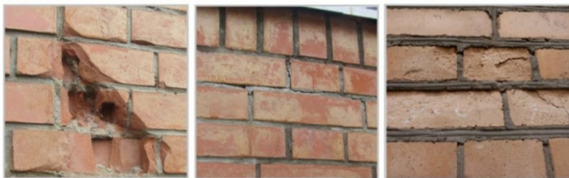
Рис. 1. Дефекты наружного слоя кирпичной кладки
