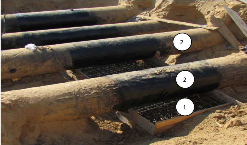
Рис. 5. Фрагмент устройства монолитного железобетонного ростверка (поз. 1) на стадии армирования под магистральные высоконапорные трубопроводы (поз. 62)
