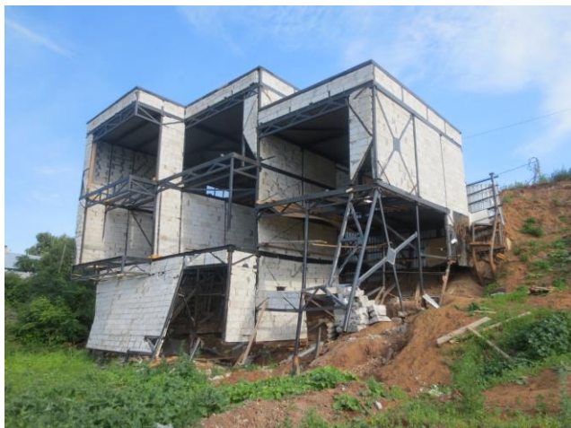
Рис. Строительство частного дома на ул. Волжской (б. Рыбацкая) в г. Чебоксары заморожено в связи с оползневыми деформациями (2016 г.)
