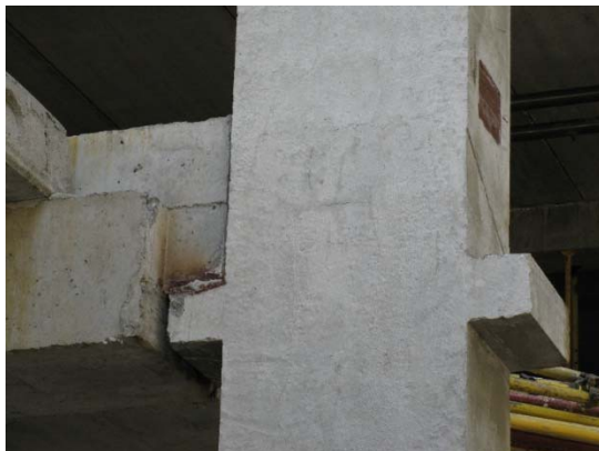
Рис. 1.15. Узел сопряжения связевого каркаса в процессе монтажа
