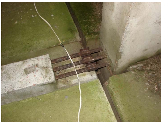
Рис. 1.20. Соединение на ванной сварке верхней арматуры ригеля с выпусками арматуры колонны
