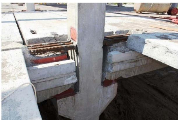
Рис. 1.18. Узел сопряжение рамного каркаса в процессе монтажа
