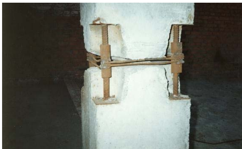
Рис. 1.11. Жесткий стык колонн с ванной сваркой до замоноличивания
