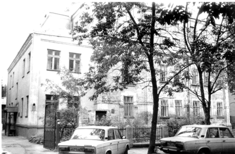
Здание юридического факультета по адресу ул. Ашхабадская, 4 / 1990-е гг.
