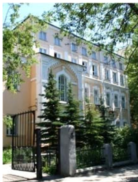
Здание юридического факультета по адресу ул. Ашхабадская, 4
