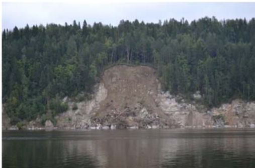
Рис. 15. Левобережье Камы. Локальный оползень-обвал сброса абразионного происхождения
