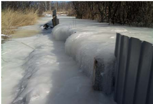
Рис. 14. Работа противофильтрационного экрана в русле ручья в зимний период
