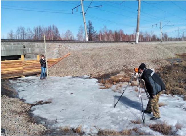
Рис. 8. Геодезическая съемка группой студентов по трассе нагорного канала
