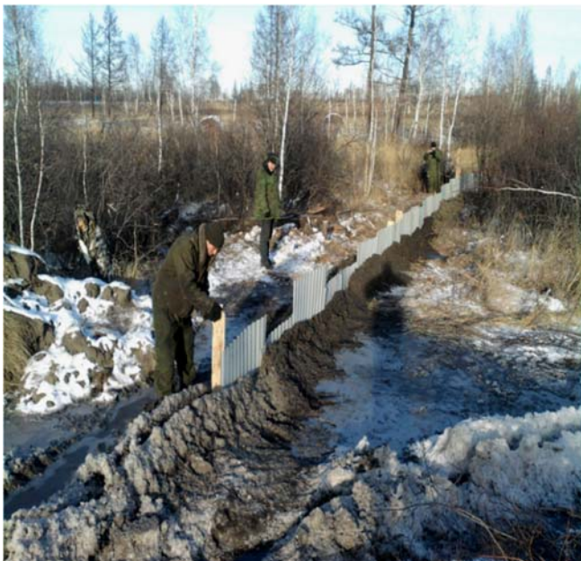
Рис. 13. Строительство противодиффузионного экрана в русле ручья
