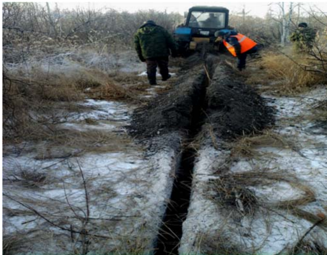
Рис. 12. Нарезка траншеи баровой машиной под противодиффузионный экран
