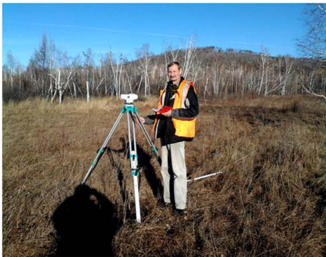
Рис. 9. Выноска трассы нагорного канала в натуру
