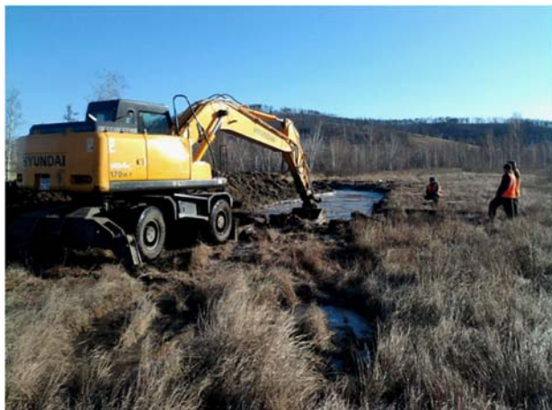
Рис. 10. Строительство нагорного канала
