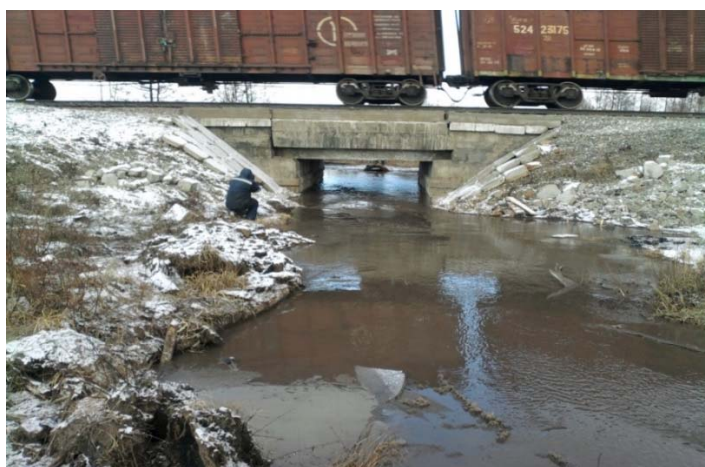
Рис. 1. Общий вид железнодорожного моста на ПК 3+75 (октябрь 2013 г.)
