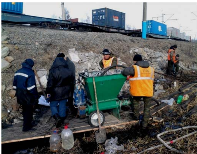
Рис. 7. Строительство противодиффузионного экрана вдоль насыпи (закачка раствора полимерного материала «Криогелит» в скважины)
