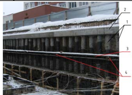
Схема устройства ограждения котлована:
