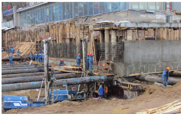
Рис. 2.14. Геотехнические работы на узле 1 по усилению существующей подпорной стены ограждения котлована котлована
