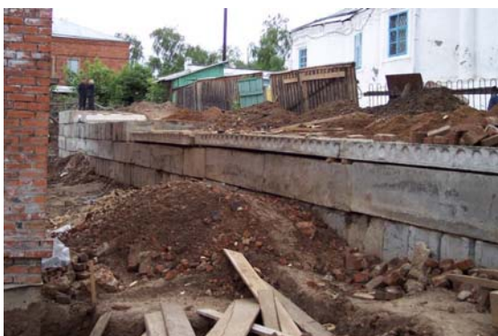
Рис. 2.9. Пригрузка бетонными блоками и плитами перекрытий с восточной стороны Введенского собора (со стороны алтаря)
