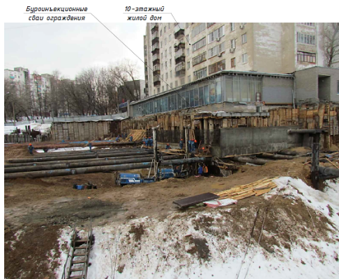
Рис. 2.12. Котлован и примыкающий к нему существующий десятиэтажный жилой дом
