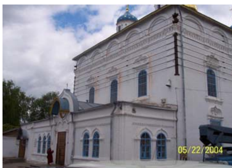
Рис. 2.8. Обвязки кирпичных стен храма из восьми рядов предварительно напряженных затяжек (вид с западного фасада)
