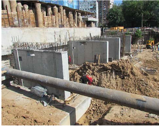
Рис. 2.18. Фрагменты выполненных монолитных железобетонных контрфорсов
