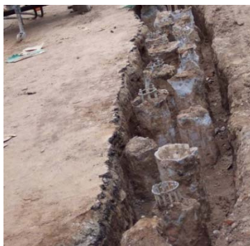
Рис. 2.7. Подпорная стенка из двух рядов буроинъекционных свай ЭРТ (РИТ, ФОРСТ, ЭРСТ) со стороны алтаря
