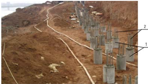
Рис. 12. Схема устройства усиления оползневого склона: 1 – буронабъекционные сваи ЭРТ (РИТ, ЭРСТ, ФОРСТ) в три ряда; 2 – выпуски арматурного каркаса свай
