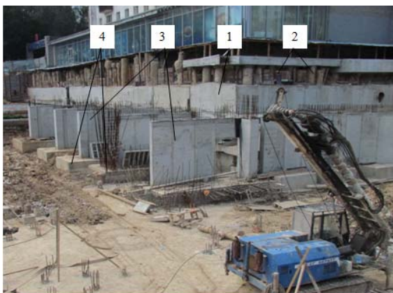
Рис. 2. Монолитные железобетонные контрфорсы на буронабивных сваях ЭРТ (РИТ, ФОРСТ, ЭРСТ) как упор деформированной подпорной стены в г. Н. Новгород: 1 – существующая монолитная железобетонная подпорная стена как упор деформированного ограждения котлована из буронабивных свай 2; 3 – монолитные железобетонные контрфорсы по монолитным железобетонным ростверкам 4
