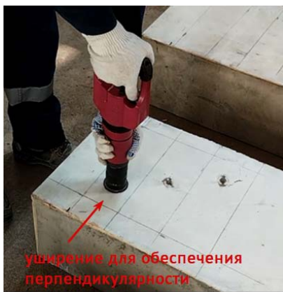
Рис. 1. Установка дюбель-гвоздей с помощью пистолета GFT 5
