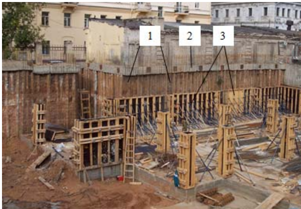
Рис. 4. Ограждение котлована из буринъекционных свай ЭРТ (РИТ, ФОРСТ, ЭРСТ) в г. Н. Новгород: 1 – ограждение котлована из двух рядов буринъекционных свай ЭРТ (РИТ, ФОРСТ, ЭРСТ); 2 – монолитный железобетонный обвязочный пояс; 3 – опалубка
