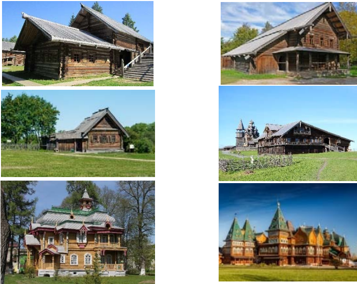
Рис. 42. Старинные русские жилые постройки: избы: Музей-заповедник деревянного зодчества «Малые Корелы» (Архангельская обл.), Владимиро-Суздальский музей-заповедник, Новгородский музей-заповедник народного деревянного зодчества «Витославицы». Музей-заповедник «Кижы» (Карелия) терем (Володарский музейный центр), царский дворец (Музей-заповедник «Коломенское», г. Москва)
