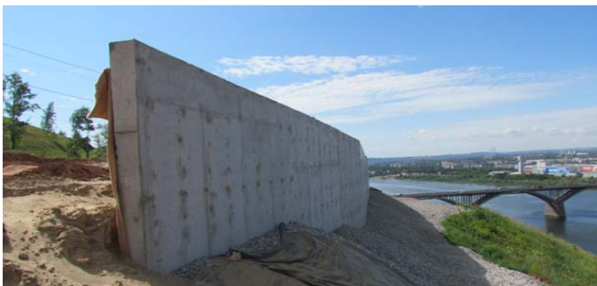
Рис. 1. Монолитная железобетонная уголковая подпорная стена как заглубленная удерживающая конструкция на буроинъекционных сваях ЭРТ (РИТ, ФОРСТ, ЭРСТ) на склоне Окского съезда в г. Н. Новгород
