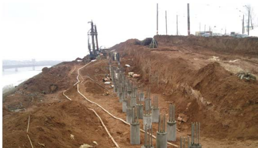
Рис. 2. Ленточное свайное поле из буроинъекционных свай ЭРТ (РИТ, ФОРСТ, ЭРСТ) под монолитную уголковую подпорную стену на Окском съезде в г. Н. Новгород
