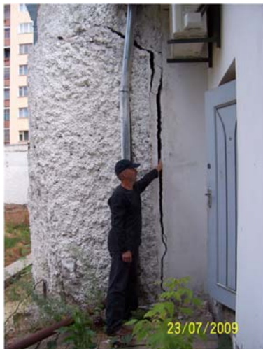
Рис. 3. Аварийное состояние вентиляционной камеры с наружной стороны несущей стены
