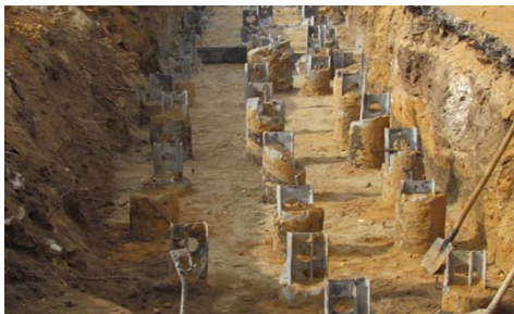
Рис. 3 Ленточное свайное поле из буронабейных свай ЭРТ (РИТ, ФОРСТ, ЭРСТ) вдоль улицы Пожарской в г. Нижний Новгород
