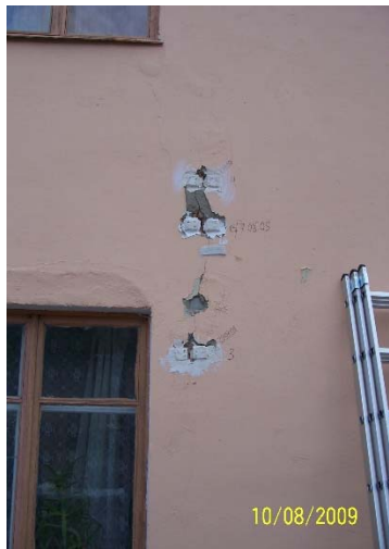
Рис. 4. Маяки конструкции Ф.А. Белякова
