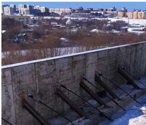
Рис. 4. Заглубленные удерживающие железобетонные конструкции с использованием буронабейных свай ЭРТ (РИТ, ФОРСТ, ЭРСТ), грунтовых анкеров ЭРТ и монолитных железобетонных угловых подпорных стен в г. Чебоксары
