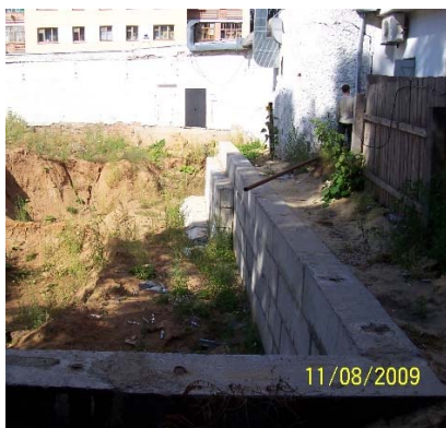
Рис. 1. Разработка котлована под новое строительство
